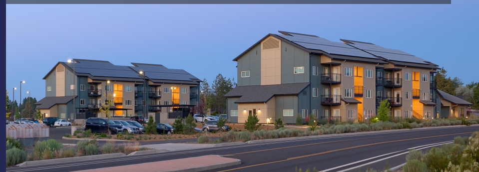
Canal Commons One 148 kW Solar PV
